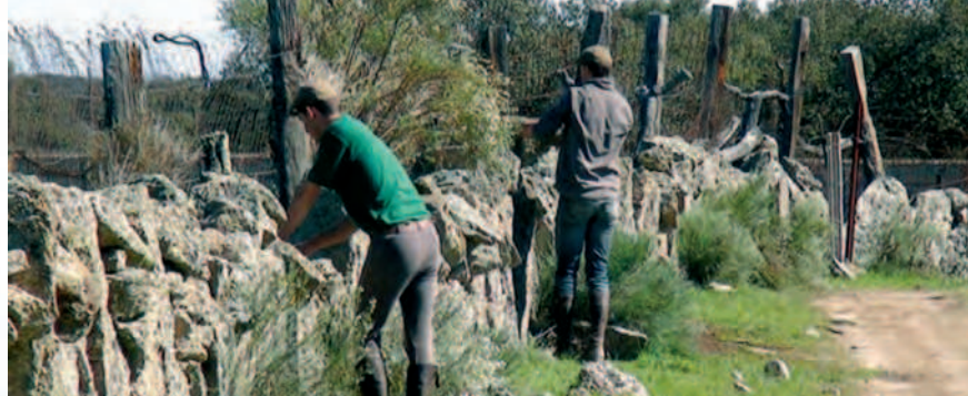
Reparación del cerramiento. Fuente: José Luis Castro, Asociación Nacional de Mayorales Reparação do cerramento. Fonte: José Luis Castro, Associação Nacional de Maiorais
